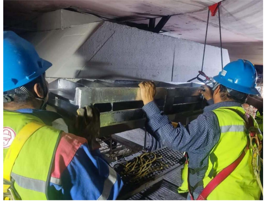
Los trabajos representan una inversión de mil millones de pesos.
