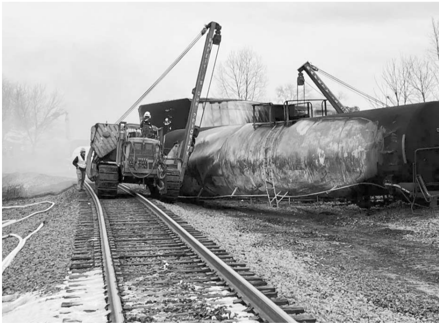
Prometen autoridades que remoción de material se hará 'muy pronto'.
