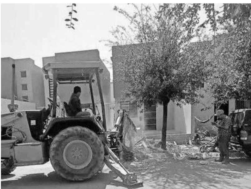
Labores de descacharrización y retiro de escombros en García.
