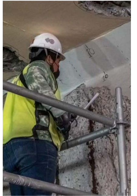
Realizan trabajos de mantenimiento en la estación Alameda.
