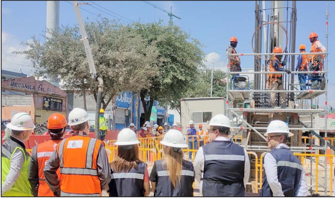
Fue en Prolongación Madero donde se realizaron los trabajos.
