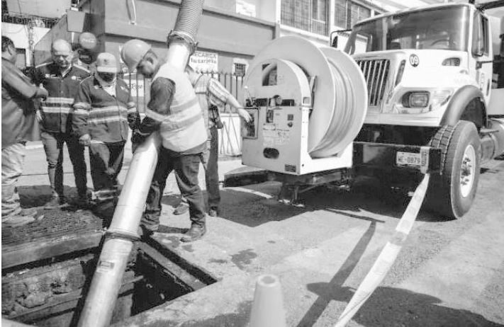
Se han retirado 3,400 toneladas de desechos de los pluviales.
