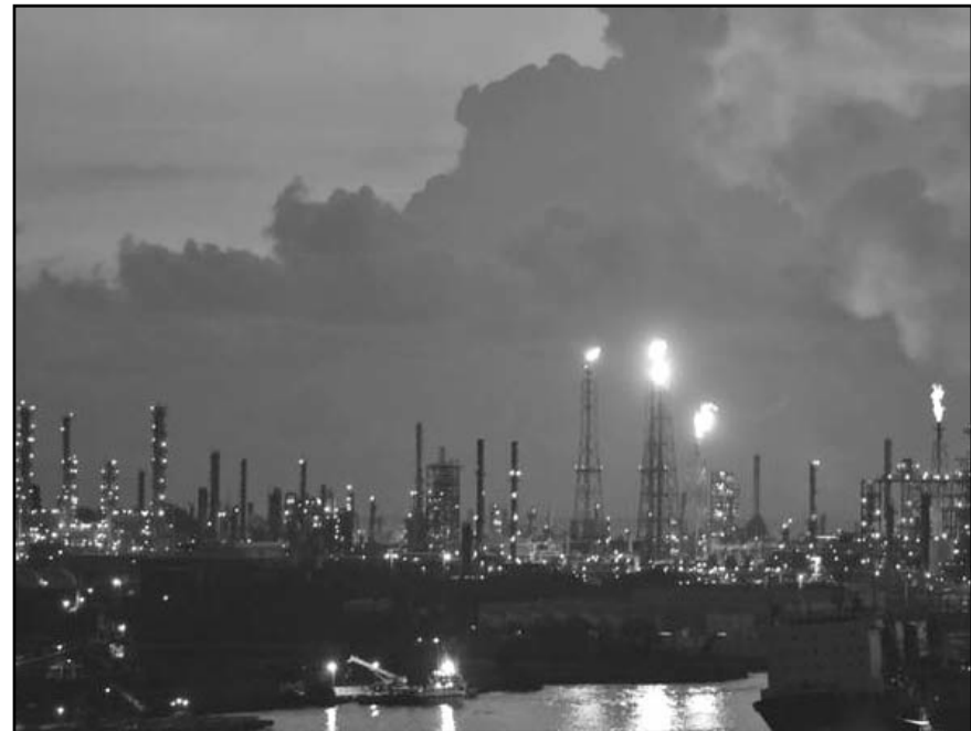
La refinería de Ciudad Madero es una de las más contaminantes.
