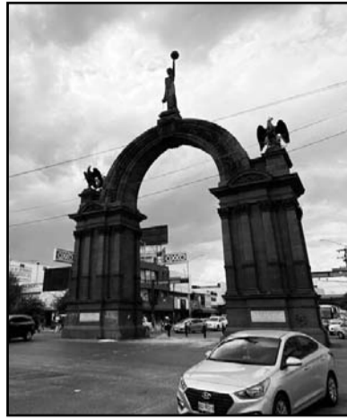
Se instalarán 42 bolardos.
