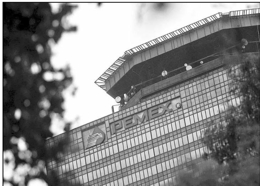
Al menos tres empresas que le dan servicios críticos han reclamado la falta de pago.
