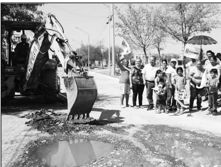
La idea es rehabilitar 13 mil metros cuadrados de pavimento
