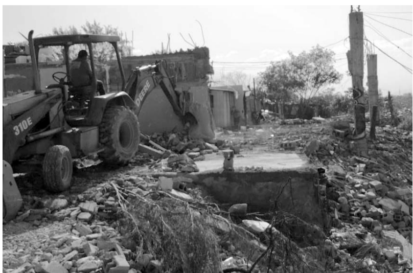
Trabajan en el rescate de 3 kilómetros del afluente.
