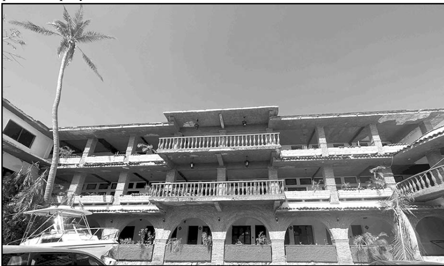
Más de 95% de los hoteles del puerto resultaron con daños de diferente magnitud.
