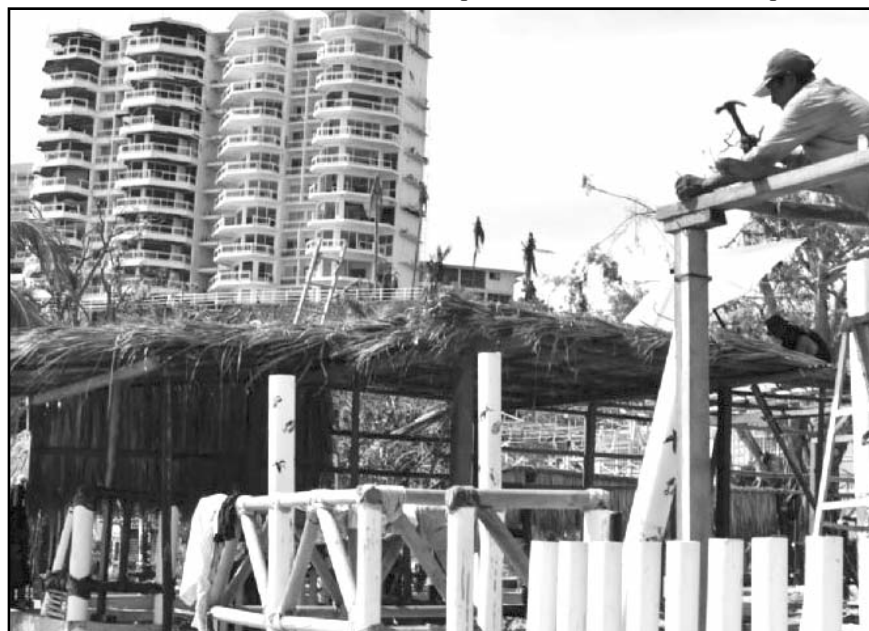
AMLO prometió que para marzo del próximo año concluirá la reconstrucción de Acapulco y Coyuca de Benítez, Guerrero
