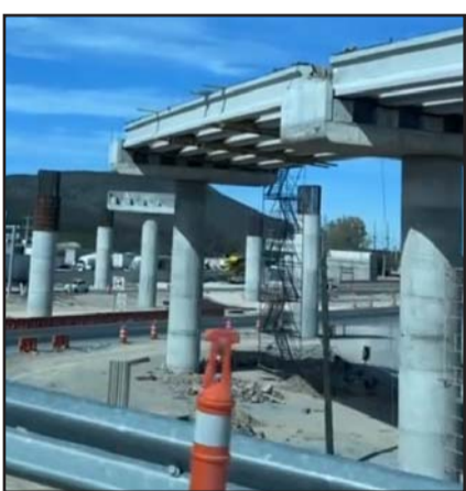
Realizó un recorrido por la obra.
