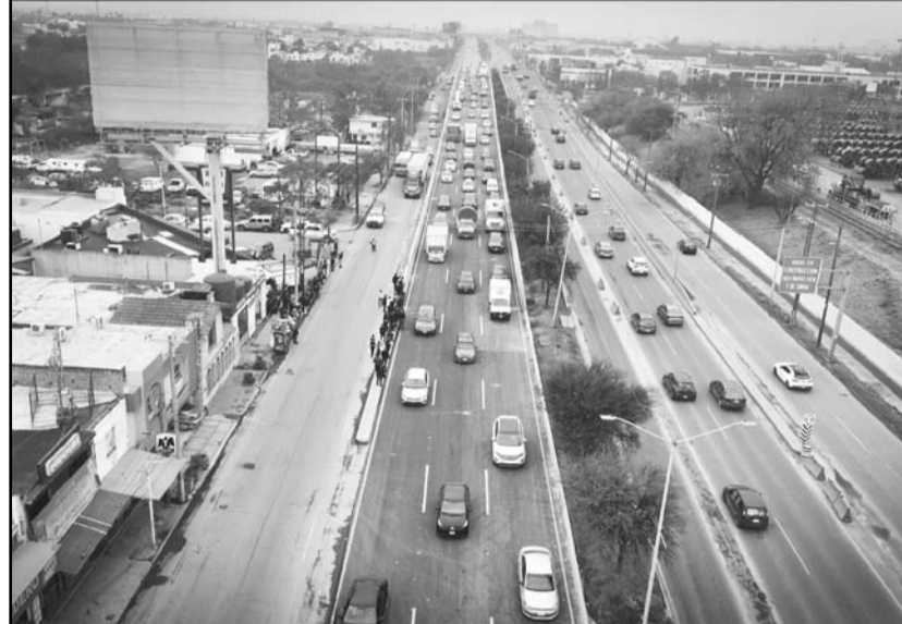
La obra tuvo una inversión de 350 millones de pesos.
