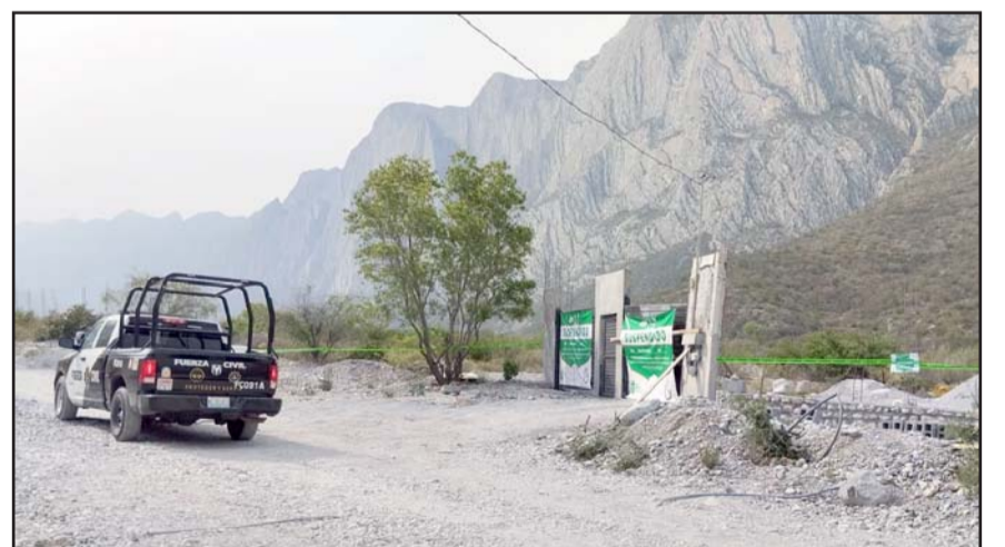
Estaban haciendo construcciones de manera ilegal.
