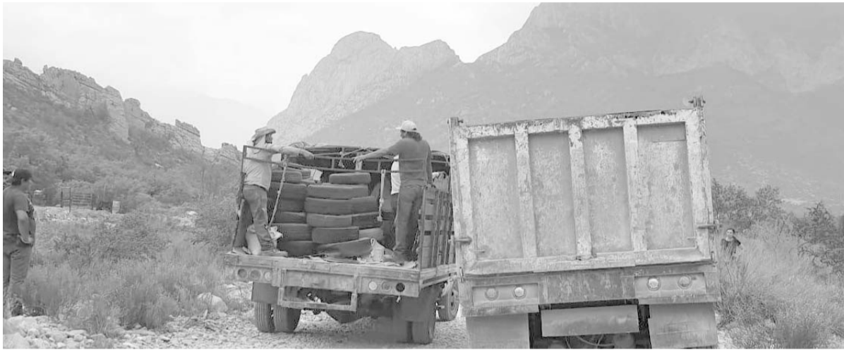
Se retiraron llantas y escombros que impacta el suelo y mantos freáticos.
