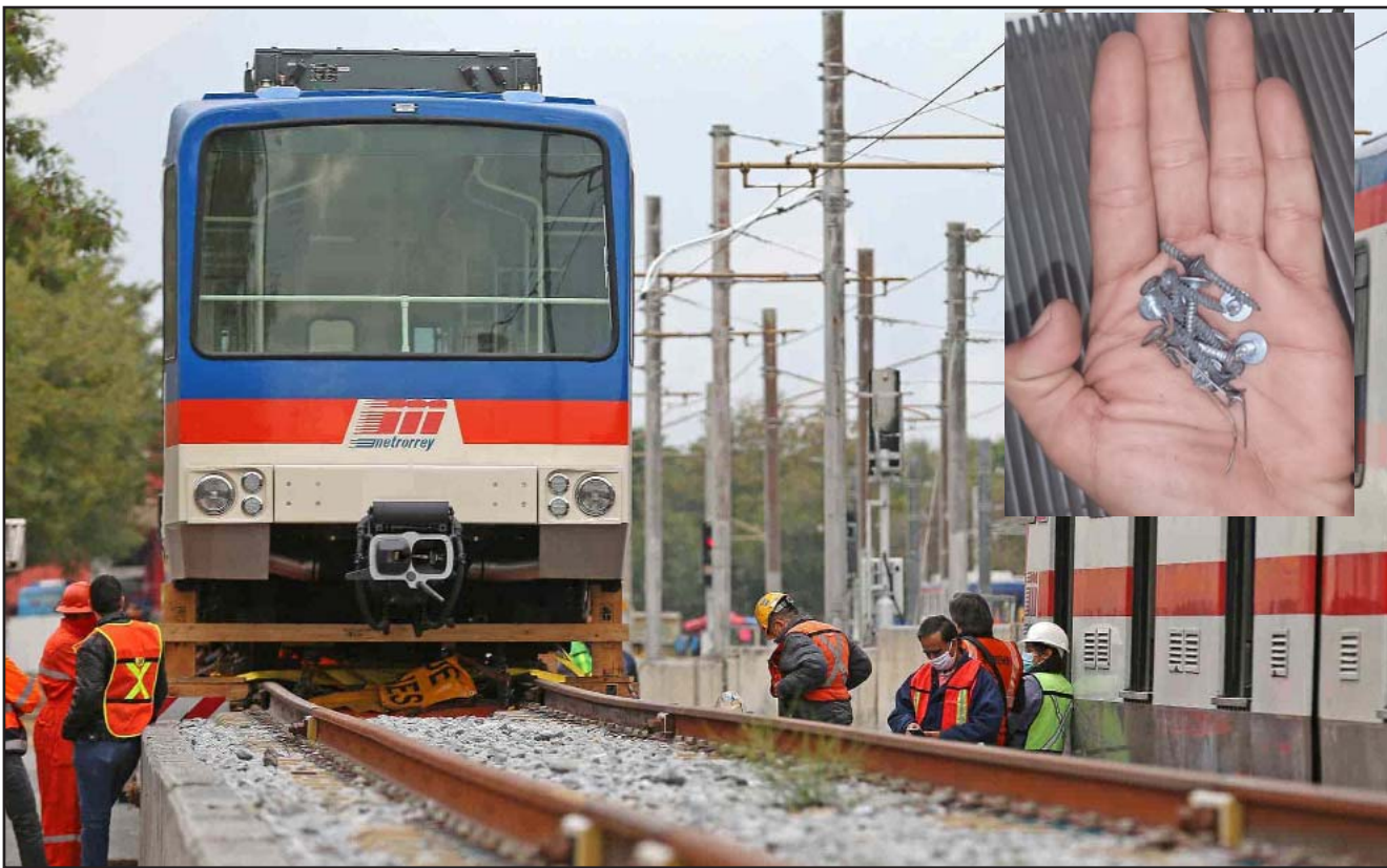
Esto se da tras el hallazgo de tornillos en las escaleras eléctricas en mantenimiento.
