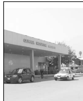
Se pudieron atender las fallas eléctricas por el calor.
