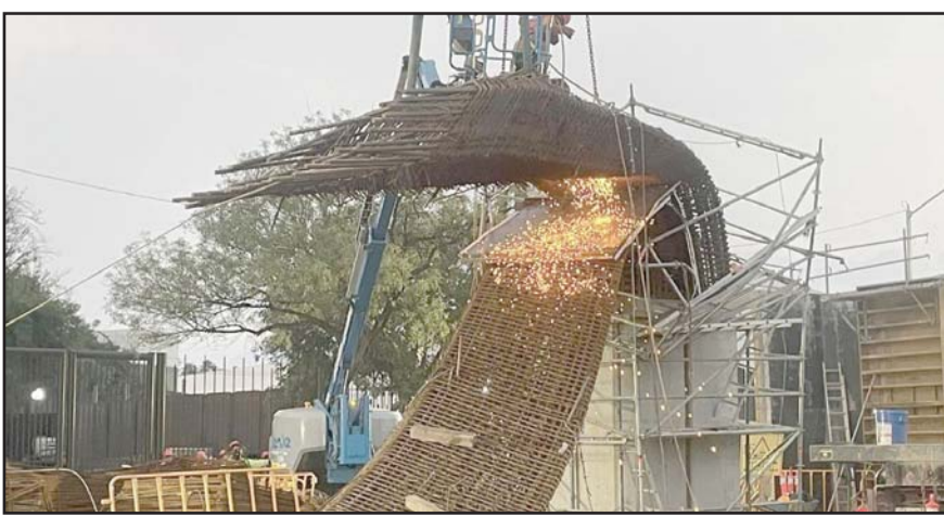
Desde temprana hora personal de la obra empezó a levantarla.
