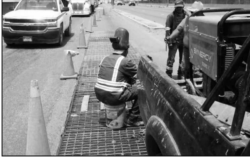
Se trabajó en algunas alcantarillas de diversas avenidas.
