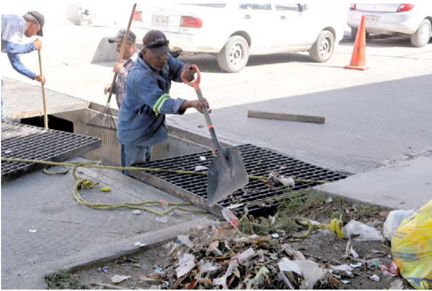
A limpiar rejillas de pluviales para evitar inundaciones.
