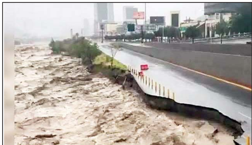
En la zona metropolitana destacan los daños al par vial Morones Prieto-Constitución.
