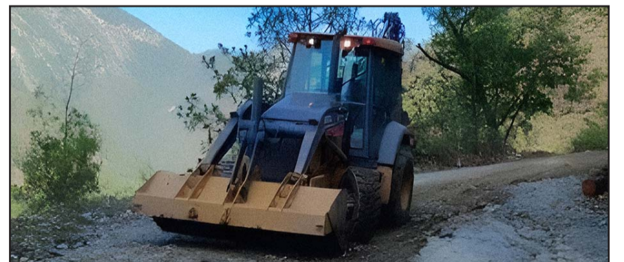
Los trabajos se hicieron en tres frentes por diferentes sectores.
