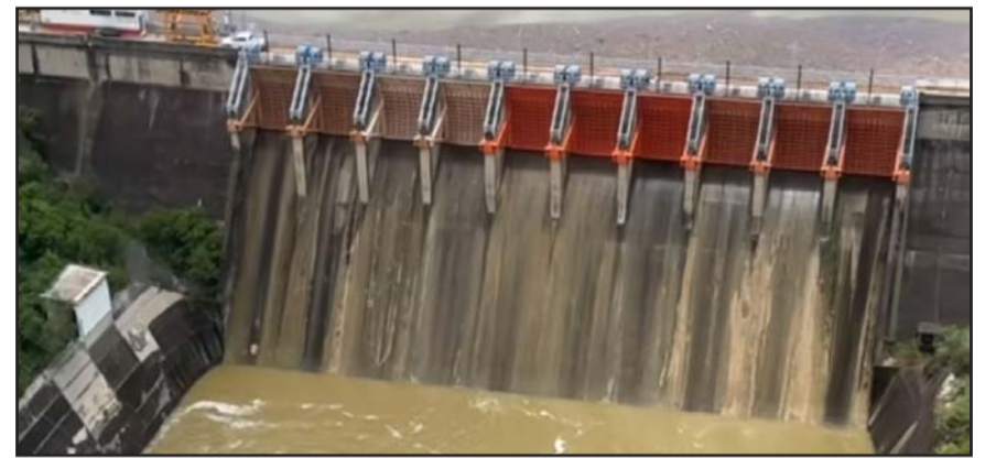
Se habían mantenido abiertas para su desfogue controlado y así evitar un posible desbordamiento ante las lluvias que se esperan.
