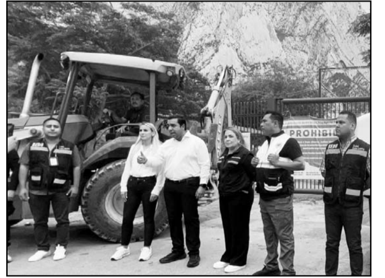
El alcalde, Jesús Nava, encabezó el inicio de las obras
