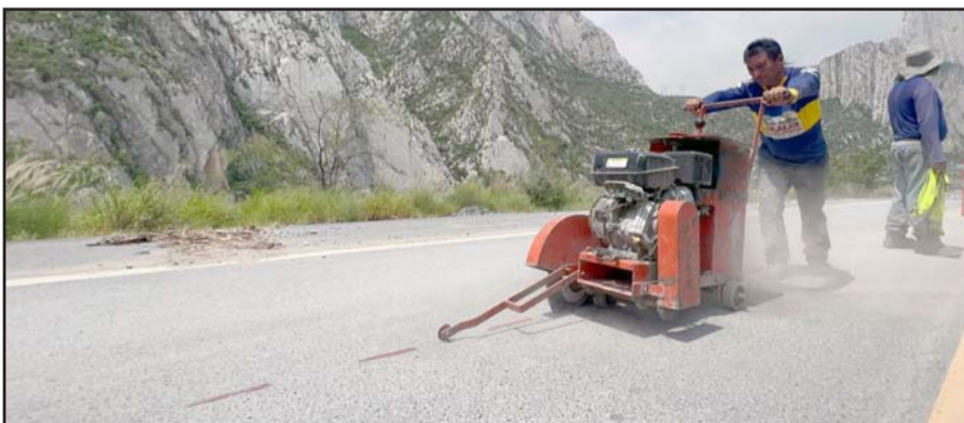
Serán aproximadamente 780 metros desde un tramo al interior de La Huasteca
