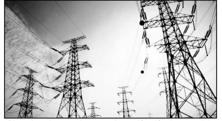
Planeaban desmantelar una subestación eléctrica para dejar sin electricidad a siete regiones del occidente del país.
