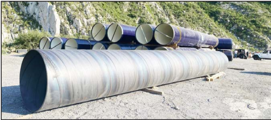
Se iniciaron las excavaciones para la introducción de los tubos en el área de La Huasteca
