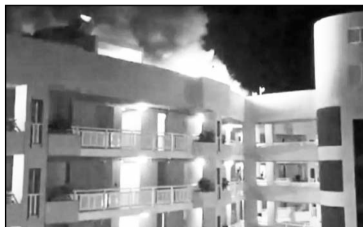
El estrellamiento de la aeronave contra el techo del hotel DoubleTree Hilton provocó un incendio.
