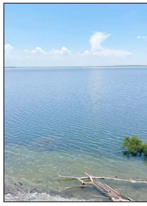
Está llena en su totalidad la presa
