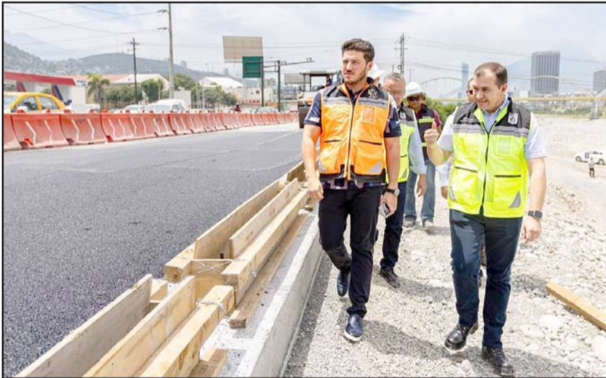
El gobernador Samuel García hizo un recorrido por las obras
