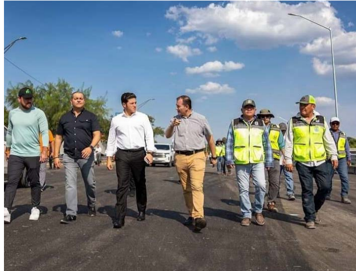
Acompañado del Subsecretario de Infraestructura, Samuel García supervisó los últimos detalles para reabrir la vialidad.
