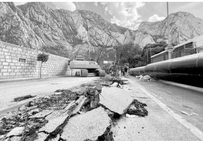
Se trabaja en la ruptura de pavimentos.
