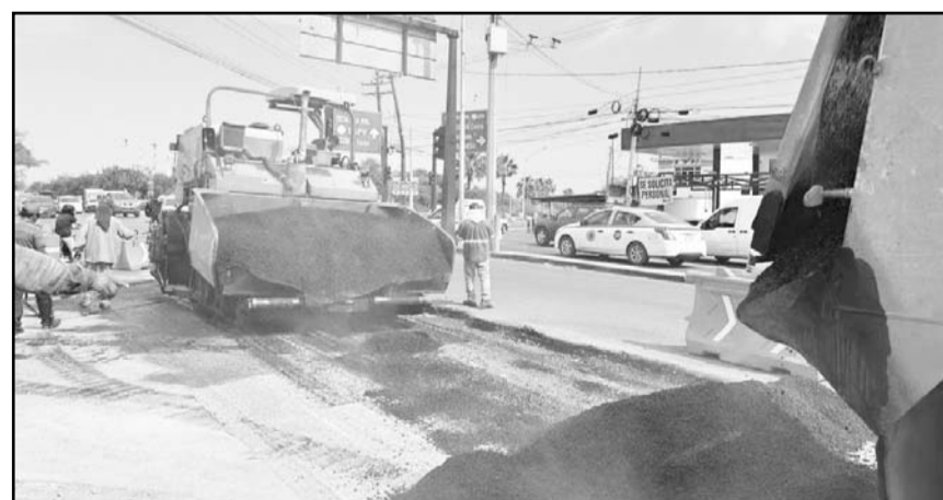
Se está trabajando a marchas forzadas para terminarlas en dos semanas
