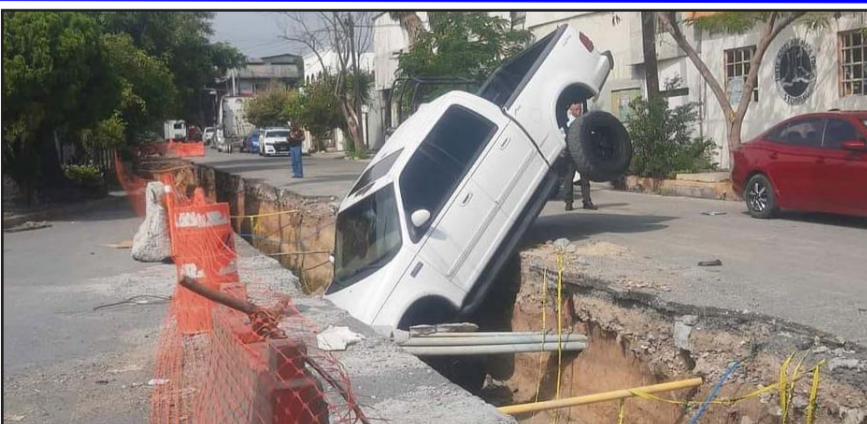
La zanja abierta es de Agua y Drenaje.
