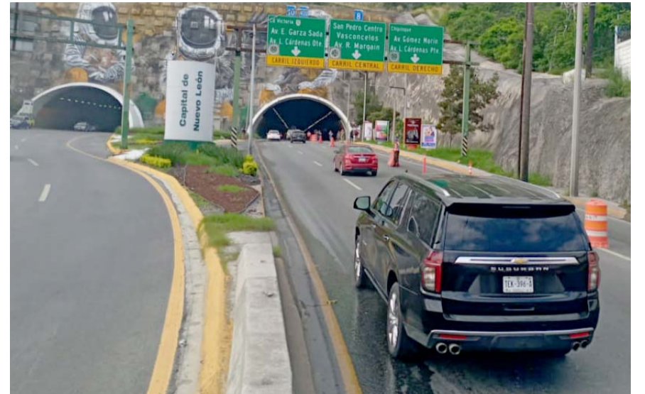
Un carril seguirá cerrado a la vialidad, mientras se siguen realizando estudios sobre la seguridad en el Túnel.
