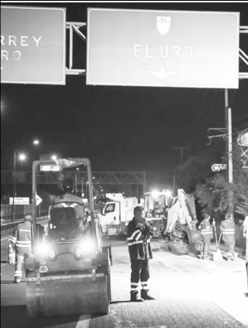
Se están haciendo trabajos por la noche.
