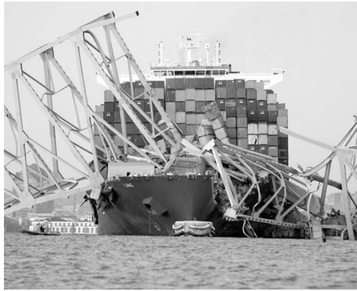
La indemnización permitirá cubrir los costos de reparación.
