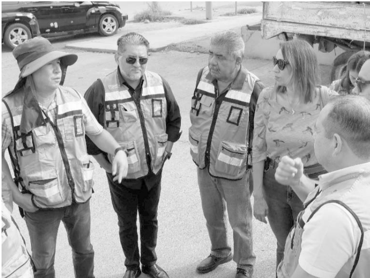
Los trabajos inician hoy en Ave. Eloy Cavazos.
